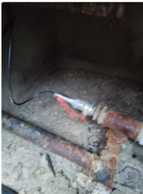
Misuratore di pressione CASTEL DI IERI (POZZETTO) ID:CDI_P03 TIPO KELLER PN 222625,2245 11/24
