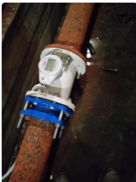
Misuratore di portata DN150 Serbatoio RIVISONDOLI GRANDE ID:RIV_Q04 CODICE: 3K220001047940
