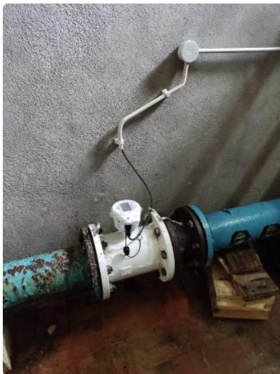
Misuratore di portata DN150 Serbatoio CANSANO ID: CAN_Q01 RIF. SCHEDA 9 CODICE:3K220001037807
