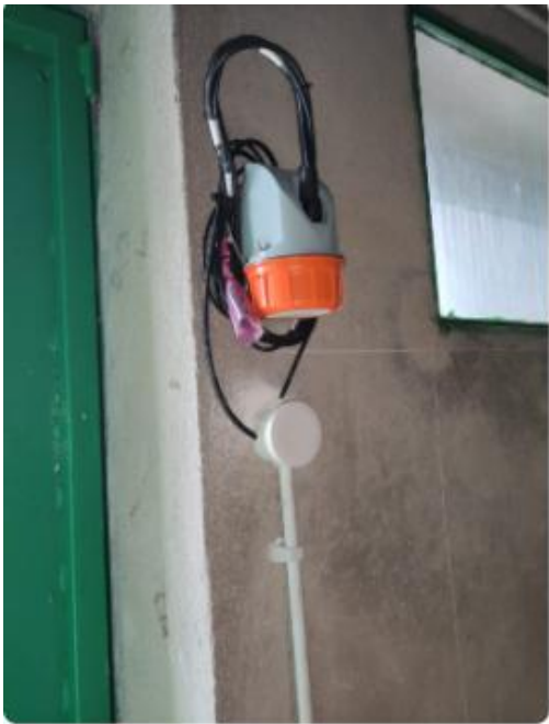
RTU PRESSIONE+PORTATA SERBATOIO CAMPO DI GIOVE (INGRESSO DA VIA DANTE 2) META80
