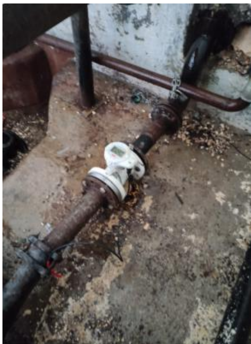
Misuratore di portata DN80 Serbatoio GAGLIANO ATERNO 2 ID: GAG_Q01 . Codice 3K220001007789
