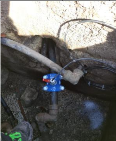
Misuratore di pressione GORIANO SICOLI ( POZZETTO) ID: GOR_P02 TIPO KELLER PN 222625,1245 11/24
