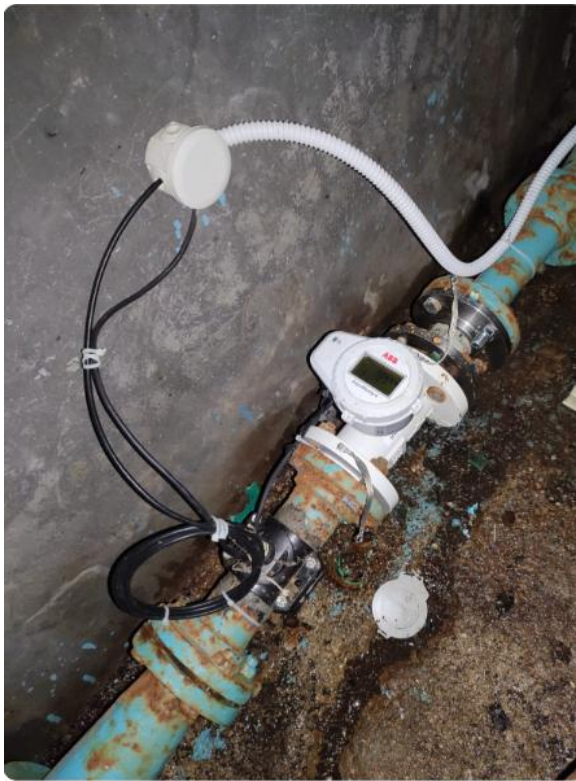
Misuratore di portata DN50 Comune PREZZA Serbatoio zona stazione ( zona bassa) codice 3K 220001007772 ID:PER_ Q01
