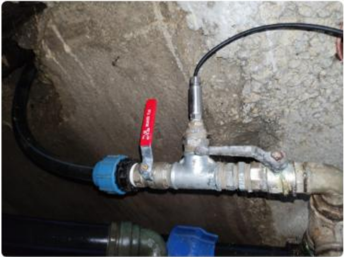
Misuratore di pressione Tipo Keller pn222625,1245 11/24 ID : ALT _ P11
