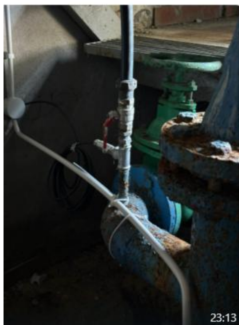
Misuratore di pressione Serbatoio VITTORITO TUBO VERSO VITTORITO TIPO KELLER PN 222625,1245
