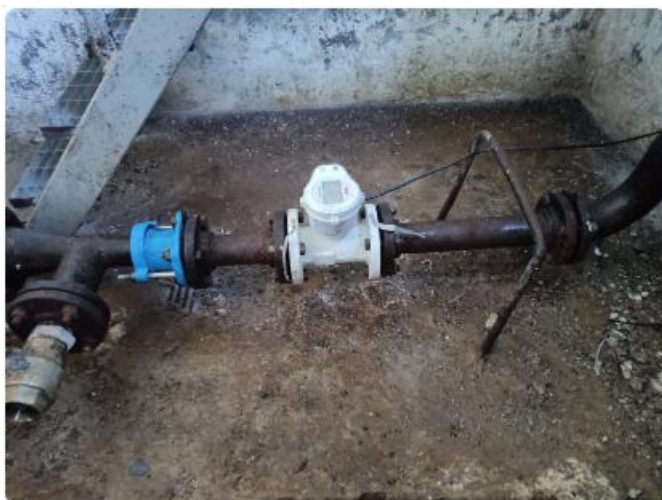
Misuratore di portata DN50 Serbatoio CASTEL DI IERI ID: CDI_Q01 Codice:3K 220001007781
