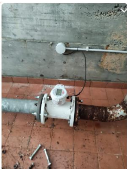
Misuratore di portata DN100 Serbatoio Molina Aterno Alto ID: MOL_Q01 Codice 3K 220001007840
