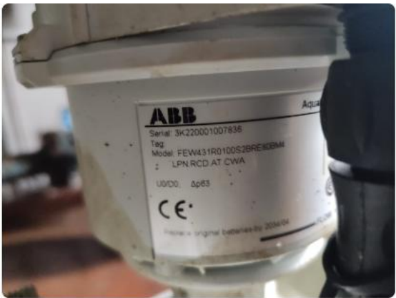
Misuratore di portata DN100 . VILLALAGO, Serbatoio Partitore Lago ID: VIL_Q03 CODICE:3K2200010036
