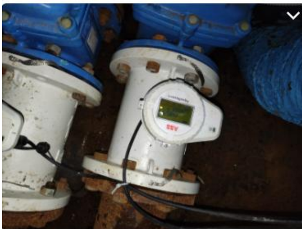
Misuratore di portata DN150 Comune CAMPO DI GIOVE Serbatoio CAMPO DI GIOVE 1 (INGRESSO DA VIA DANTE 2) ID:CDG_Q02 CODICE 3K 220001047957
