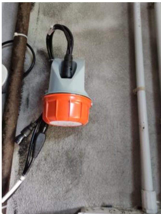
RTU . Pressione+ portata Serbatoio CANSANO META 17 ,Sim 006921939
