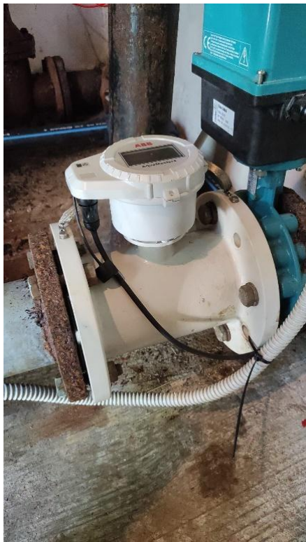
Misuratore di portata Dn 100 Torre dei Nolfi (Serbatoio Comunale) ID: BUG_Q04 Codice: 3K220001007813
