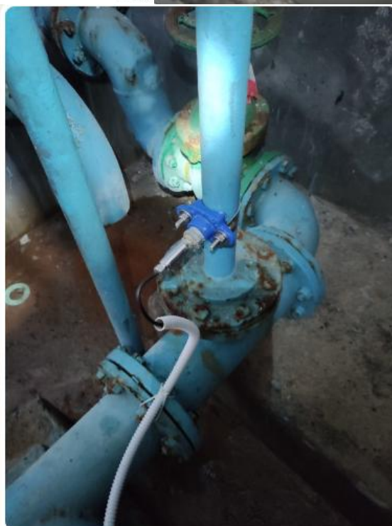
Misuratore di pressione Comune PREZZA Serbatoio zona media ID: PER_P02 TIPO KELLER PN 222625 ,1245 11/24
