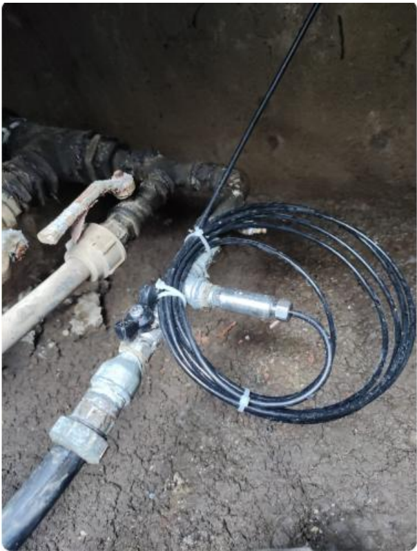
Misuratore di pressione COCULLO CASALE POZZETTO ID: COC_P06 TIPO KELLER PN:222625 1245 11/24
