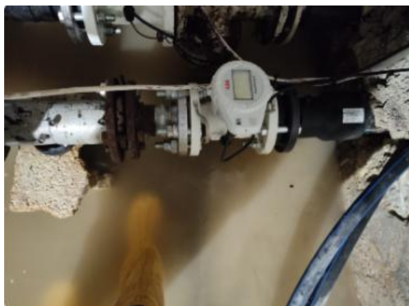
Misuratore di portata DN50 ATELETA, Serbatoio Ateleta 1Alto ID: ATL_Q10 Codice:3K220001007774
