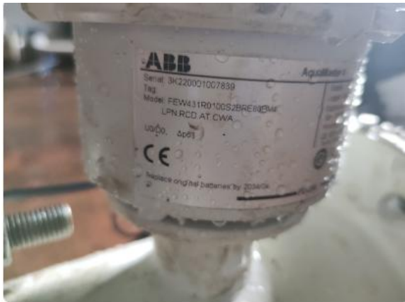
Misuratore di portata DN100 VILLALAGO, Serbatoio Partitore Lago ID: VIL_Q02. CODICE:3K22001007839
