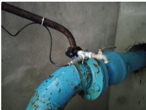
Misuratore di pressione Serbatoio CANSANO ID:CAN_P01 TIPO KELLER PN 222625,1245 11/24
