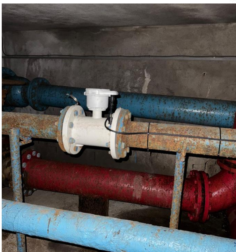
Serbatoio PRATOLA PELIGNA N1 MISURATORE DI PORTATA DN100 CODICE 3K 220001007820
