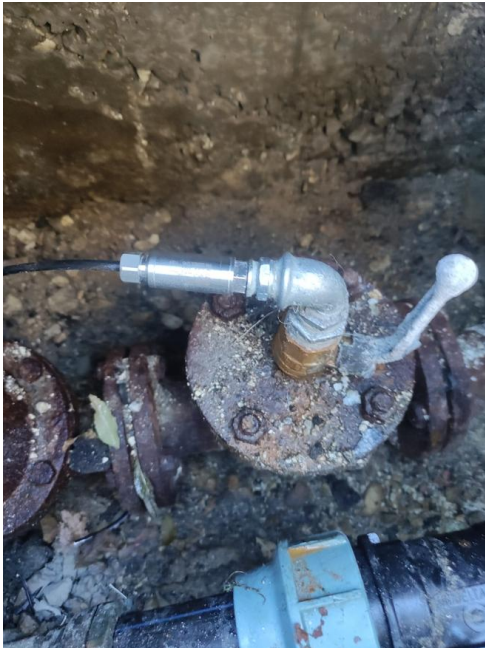
TRASDUTTORE DI PRESSIONE Keller RETE VILALAGO PAESE ID: VIL_P07
