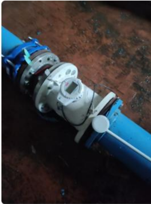
Misuratore di portata DN200 CAMPO DI GIOVE SERBATOIO CAMPO DI GIOVE (INGRESSO DA VIA DANTE 2)
