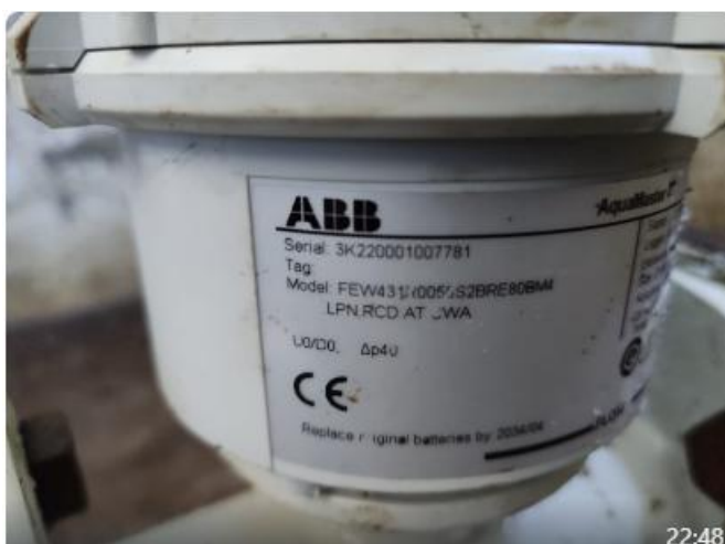
Misuratore di portata DN50 Serbatoio CASTEL DI IERI ID: CDI_Q01 Codice:3K 220001007781
