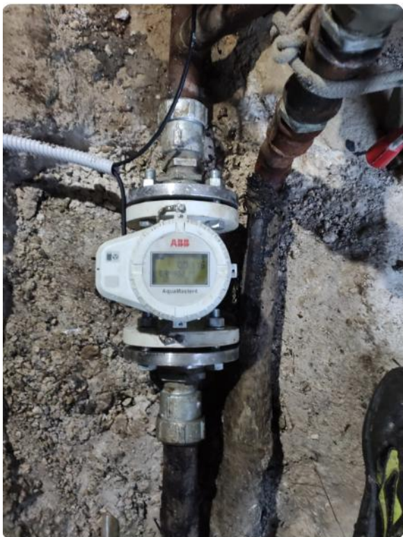
Misuratore di portata DN50 COMUNE PREZZA SERBATOIO ZONA ALTA ID: PER_ Q04 COD: 3K220001007765
