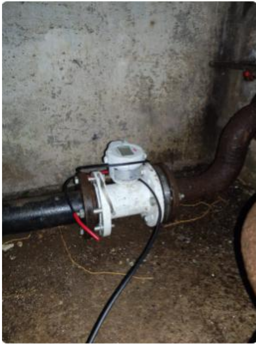
Misuratore di portata DN80 Serbatoio Molina Aterno Basso ID: MOL: Q02 Codice: 3k220001007804
