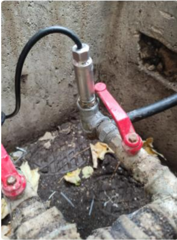
Misuratore di pressione Pozzetto CANSANO ID:CAN_P03 TIPO KELLER PN 222625,1245 11/24
