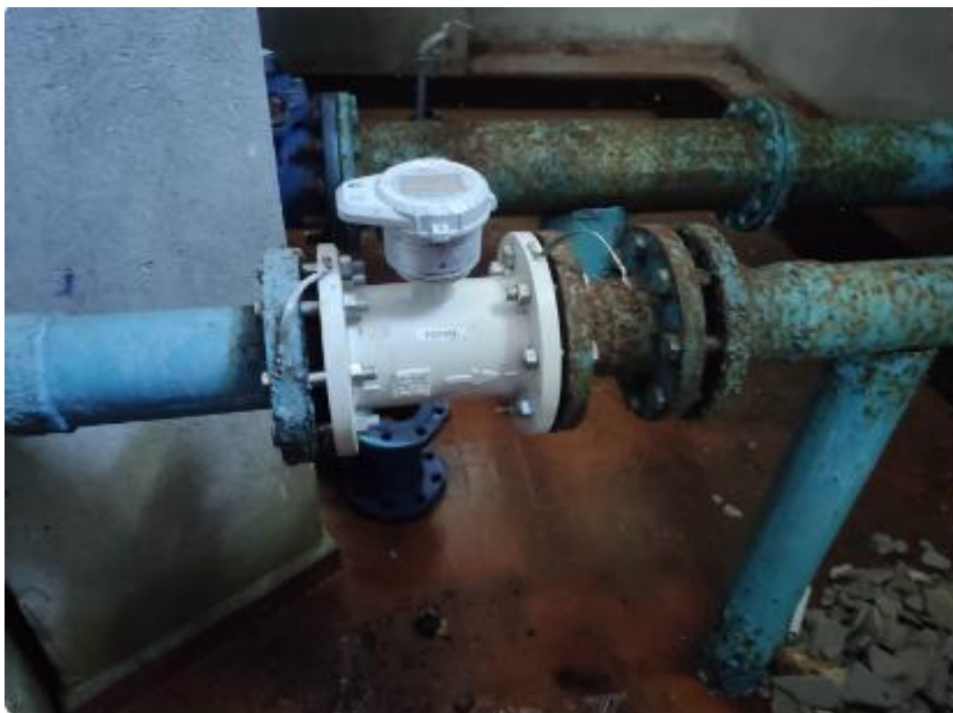
Serbatoio PRATOLA PELIGNA N1 Misuratore di portata DN100 Codice 3K 220001007814
