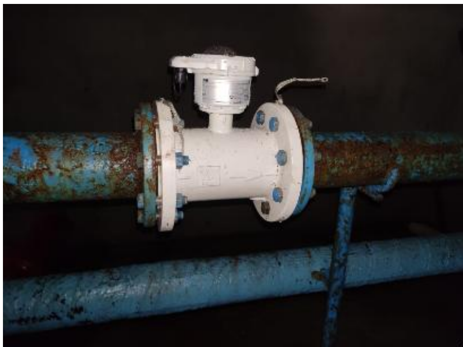
Serbatoio PRATOLA PELIGNA N1 MISURATORE DI PORTATA DN100 CODICE 3K 220001007820
