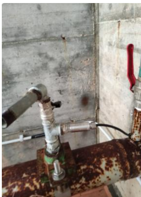
Misuratore di pressione Serbatoio Molina Aterno Alto ID : Mol_P01 Tipo Keller pn: 222625 ,1245 11/24
