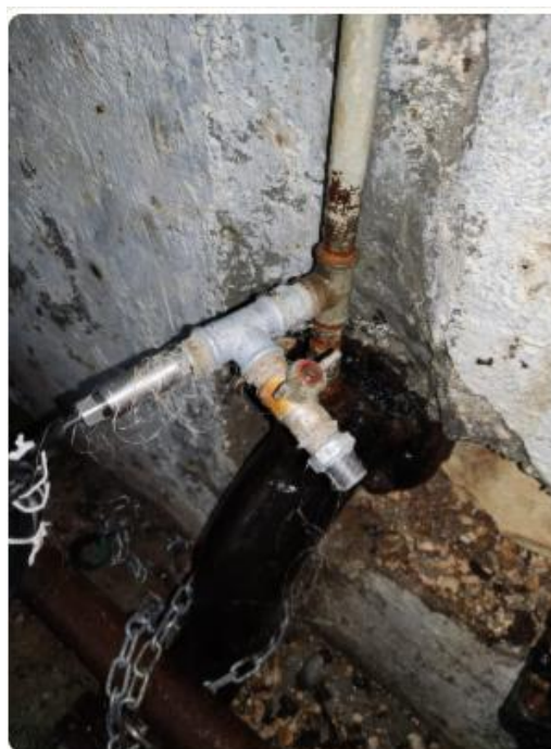
Misuratore di pressione Serbatoio GAGLIANO ATERNO 2 ID:GAG_P01 TIPO KELLER PN: 222625,1245 11/24
