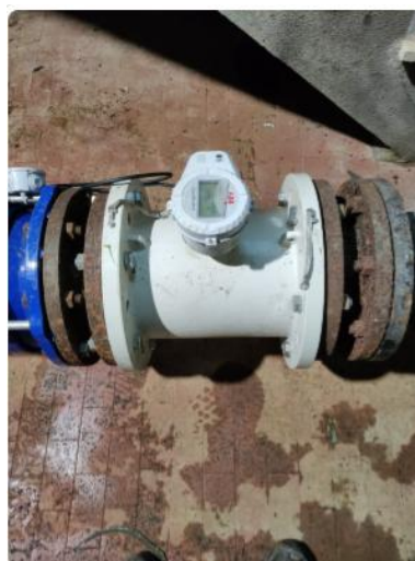
Misuratore di portata DN200 Serbatoio PARTITORE di Rivisondoli ID:RIV_Q02 Codice 3K 220001037811
