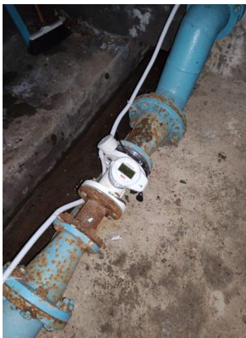
Misuratore di portata DN80 COMUNE: PREZZA SERBATOIO ZONA MEDIA ID PER_Q02 CODICE 3K 220001007799
