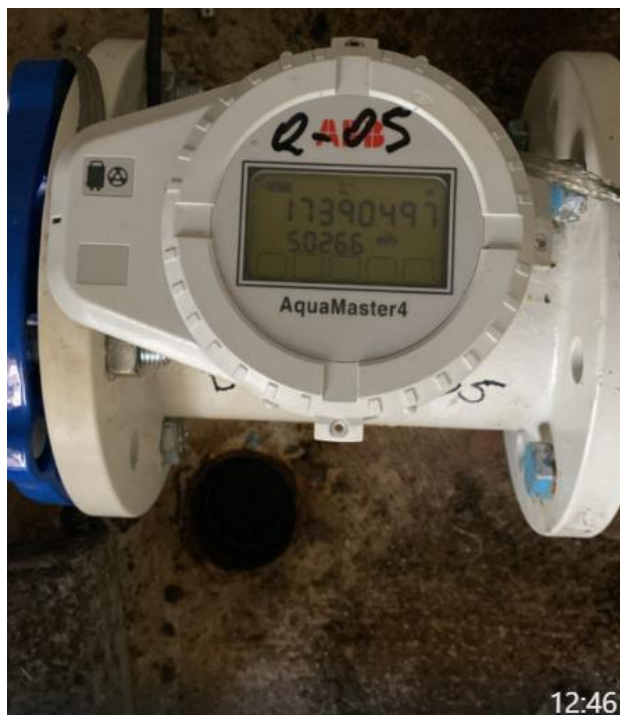
Misuratore di portata Dn 100 Torre dei Nolfi (Serbatoio Comunale) ID: BUG_Q04 Codice: 3K220001007813
