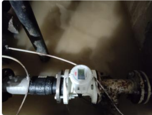
Misuratore di portata DN80 ATELETA, Serbatoio Ateleta 1Alto ID . ATL_Q08 Codice:3K220001007794
