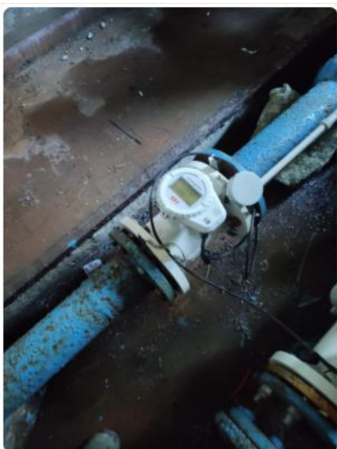
Misuratore di portata DN100 VITTORITO Serbatoio VITTORITO ( tubo Vittorito) Codice 3K 220001007837
