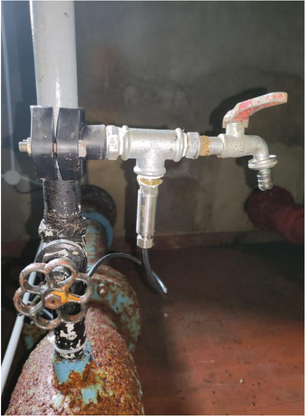
Misuratore di pressione-Serbatoio ID: VIL_P02
