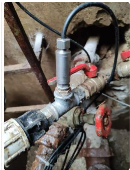
Misuratore di pressione POZZETTO PETTORANO SUL GIZIO ID :PET_P05 TIPO KELLER PN 222625,1245 11/24
