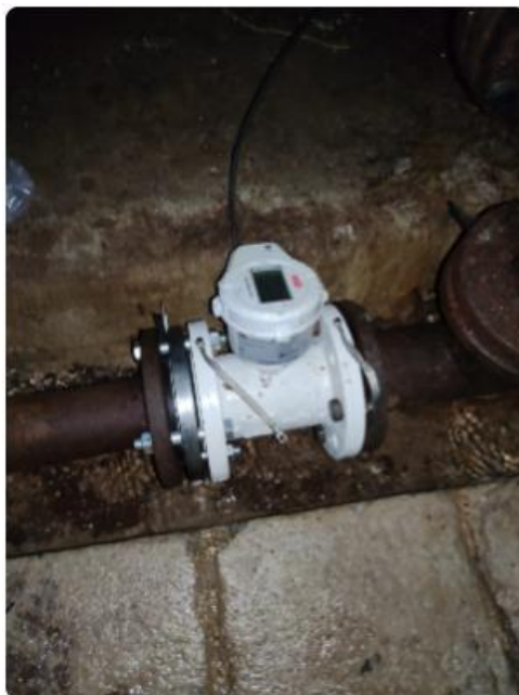
Misuratore di portata DN80 Serbatoio Molina Aterno Basso ID: MOL_Q03 Codice 3K 220001007800
