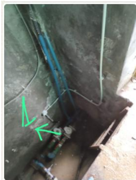
Misuratore di portata1 , DN50 ATELETA, Serbatoio CARCERI ALTE ID:Alt_q01 Codice 3K 220001007757
