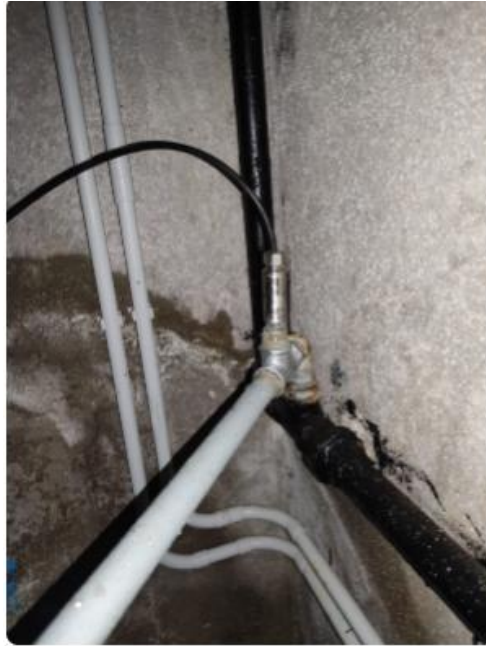
Misuratore di pressione Serbatoio CAMPO DI GIOVE (INGRESSO DA VIA DANTE 2) ID:CDG_P02 TIPO: KELLER PN 222625 ,1245 11/24
