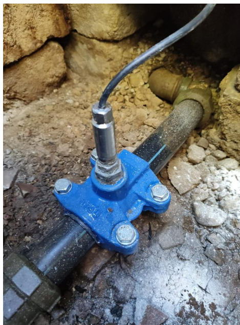
Misuratore di pressione BUGNARA (Rete comunale pozzetto) ID: BUG_P04
