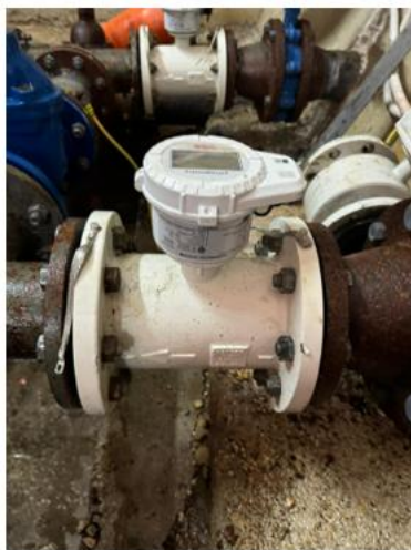
Misuratore di portata Dn 100 BUGNARA (Serbatoio Comunale) ID: BUG_Q02 Codice: 3K220001007822
