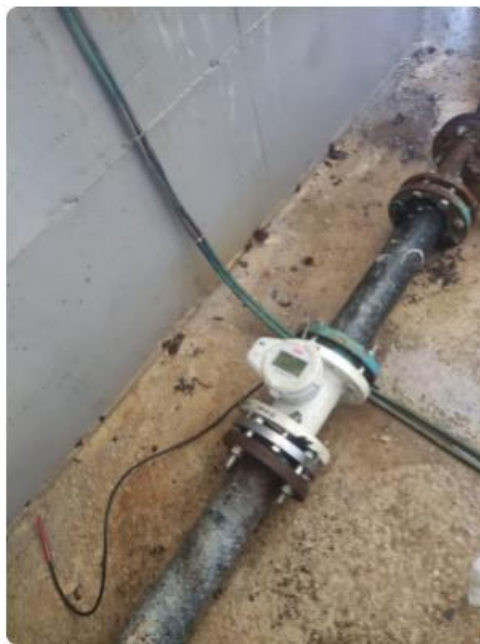
Misuratore di portata DN80 Serbatoio GAGLIANO ATERNO 1 ID:GAG_Q03 CODICE 3K220001007791
