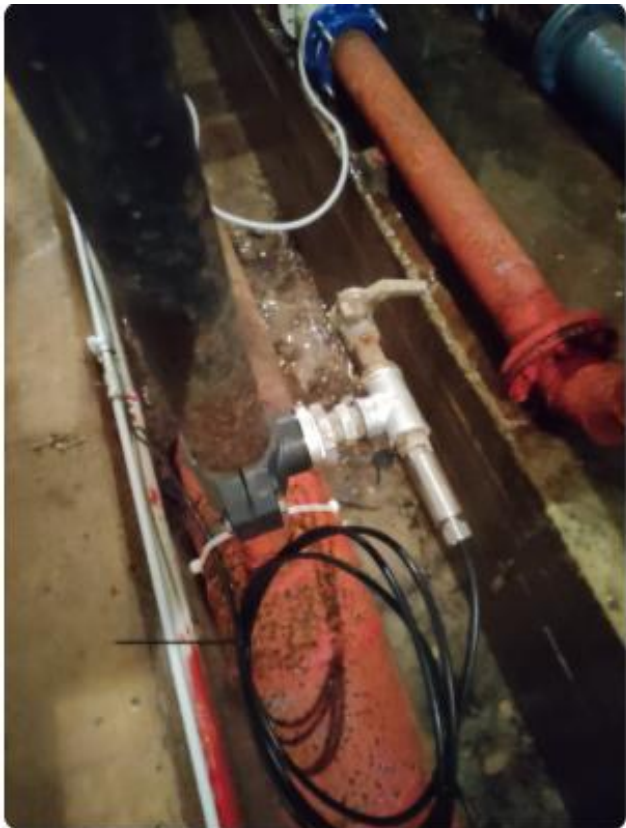
Misuratore di pressione Serbatoio Rivisondoli grande ID_RIV_P02 TIPO KELLER PN 222625,1245 11/24
