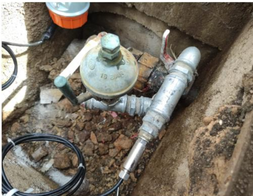
Misuratore di pressione, COCULLO _ POZZETTO ID: COC_P05 TIPO KELLER PN:222625 1245 11/24
