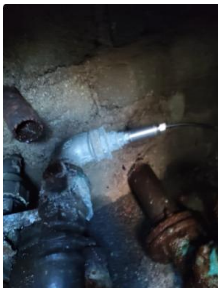
Misuratore di pressione GORIANO SICOLI ( POZZETTO) ID:GOR_P03 TIPO KELLER PN 222625,1245 11/24 RIF SCHEDA 24
