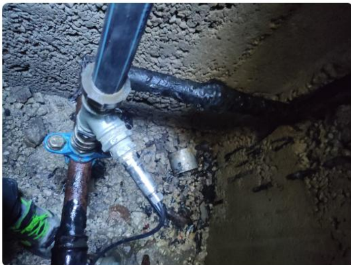
Misuratore di pressione COCULLO Pozzetto.
