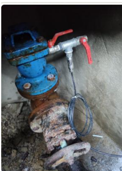
Misuratore di pressione (pozzetto) Gagliano Aterno ID:GAG_P04 TIPO KELLER PN 222625,1245 11/24
