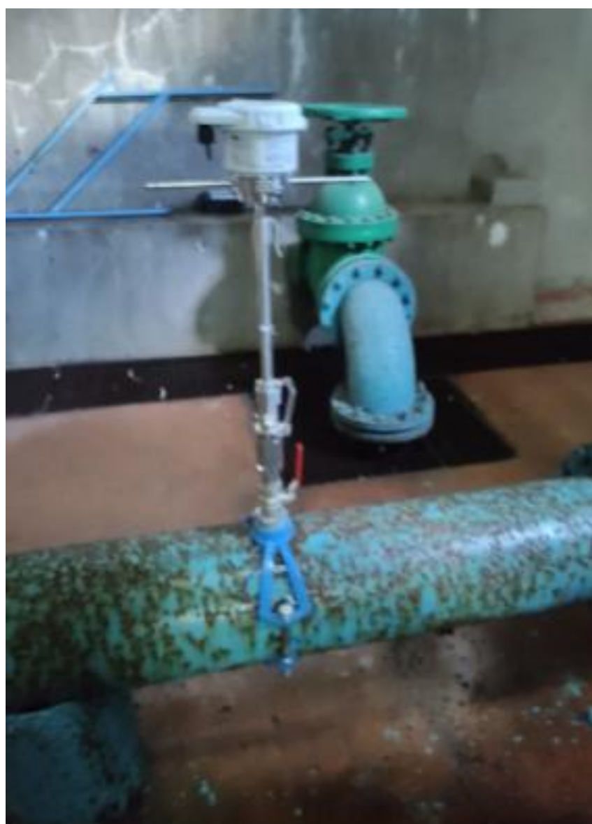
Serbatoio PRATOLA PELIGNA N1 Misuratore di portata (INSERTION SENSOR) CODICE 3K220001037813
