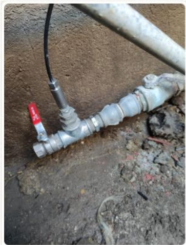
Misuratore di pressione (pozzetto) Gagliano Aterno ID:GAG_P03 TIPO KELLER PN 222626,1245 11/24 RIF SCHEDA 22
