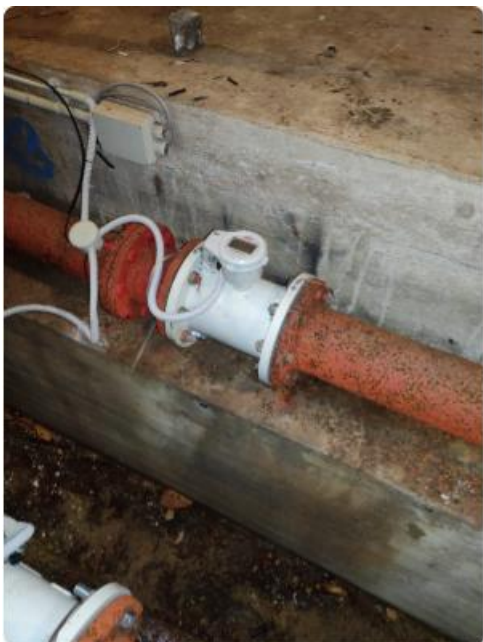
Misuratore di portata DN150 COMUNE RIVISONDOI Serbatoio Grande ID:RIV_Q03 Codice:3k220001047955
