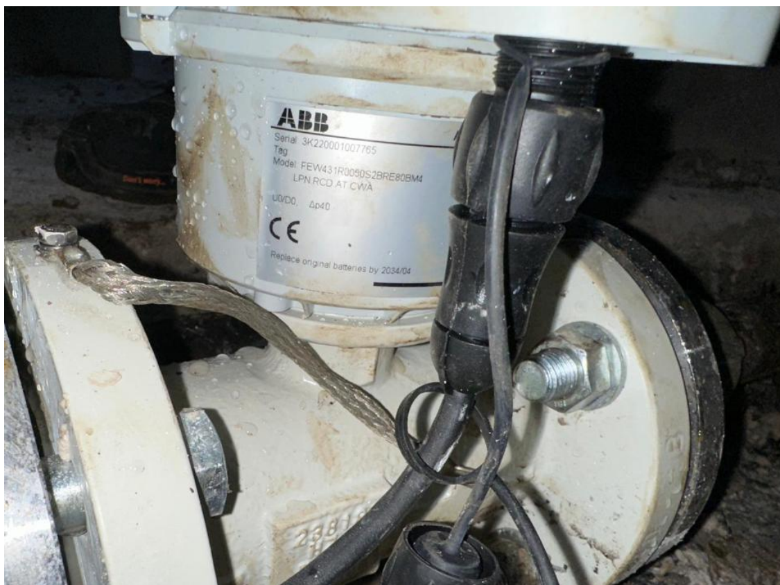
Misuratore di portata DN50 COMUNE PREZZA SERBATOIO ZONA ALTA ID: PER_ Q04 COD: 3K220001007765
