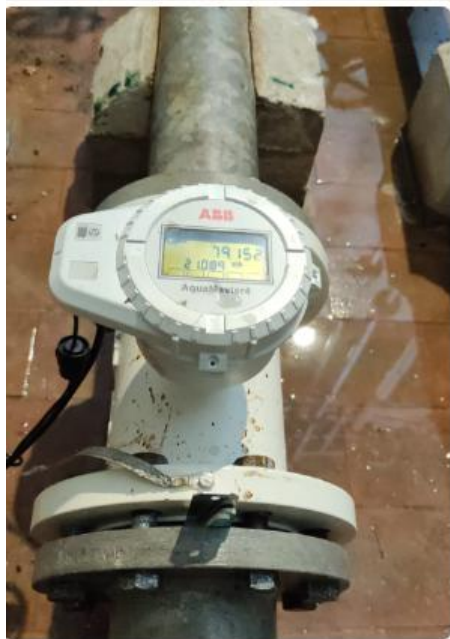
Misuratore di Portata DN100. Serbatoio GORIANO SICOLI. ID:GOR_Q01 CODICE: 3K220001007819
