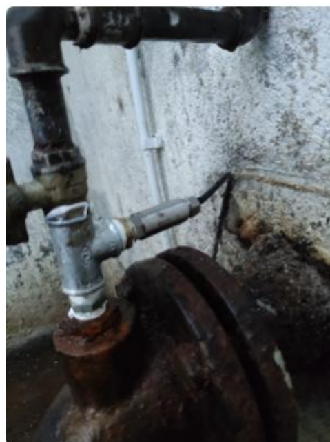
Misuratore di pressione Serbatoio castel di ieri IE: CDI_P01 TIPO KELLER PN:222625,1245. 11/24
