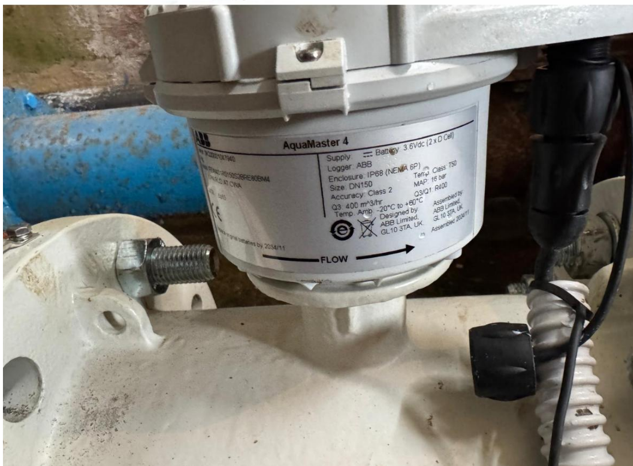
Misuratore di portata DN150 COMUNE RIVISONDOI Serbatoio Grande ID:RIV_Q03 Codice:3k220001047955
