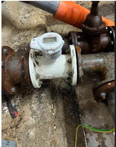
Misuratore di portata Dn 100 BUGNARA (Serbatoio Comunale) ID: BUG_Q03 Codice: 3K220001007829
