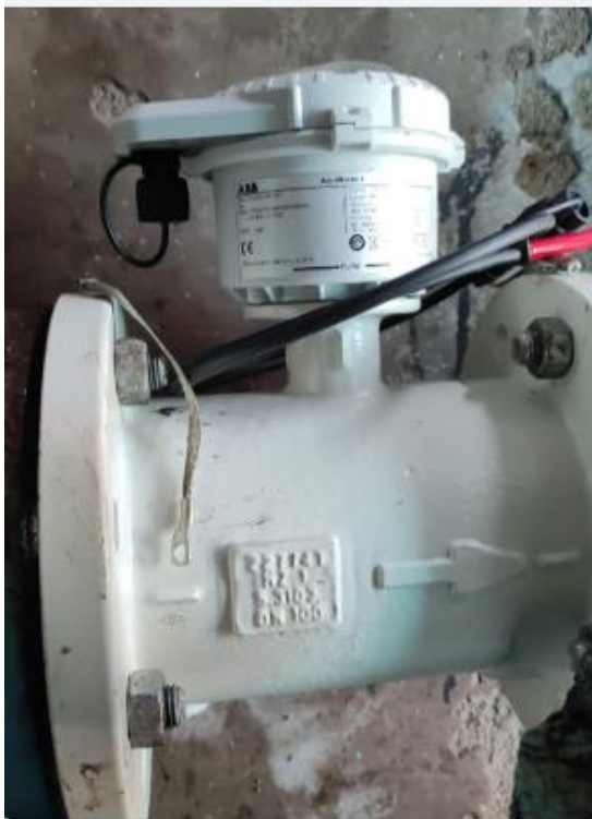
Misuratore di portata DN100. ATELETA : serbatoio PITASSI . ID:ATL_Q03. Codice :3K220001007818
