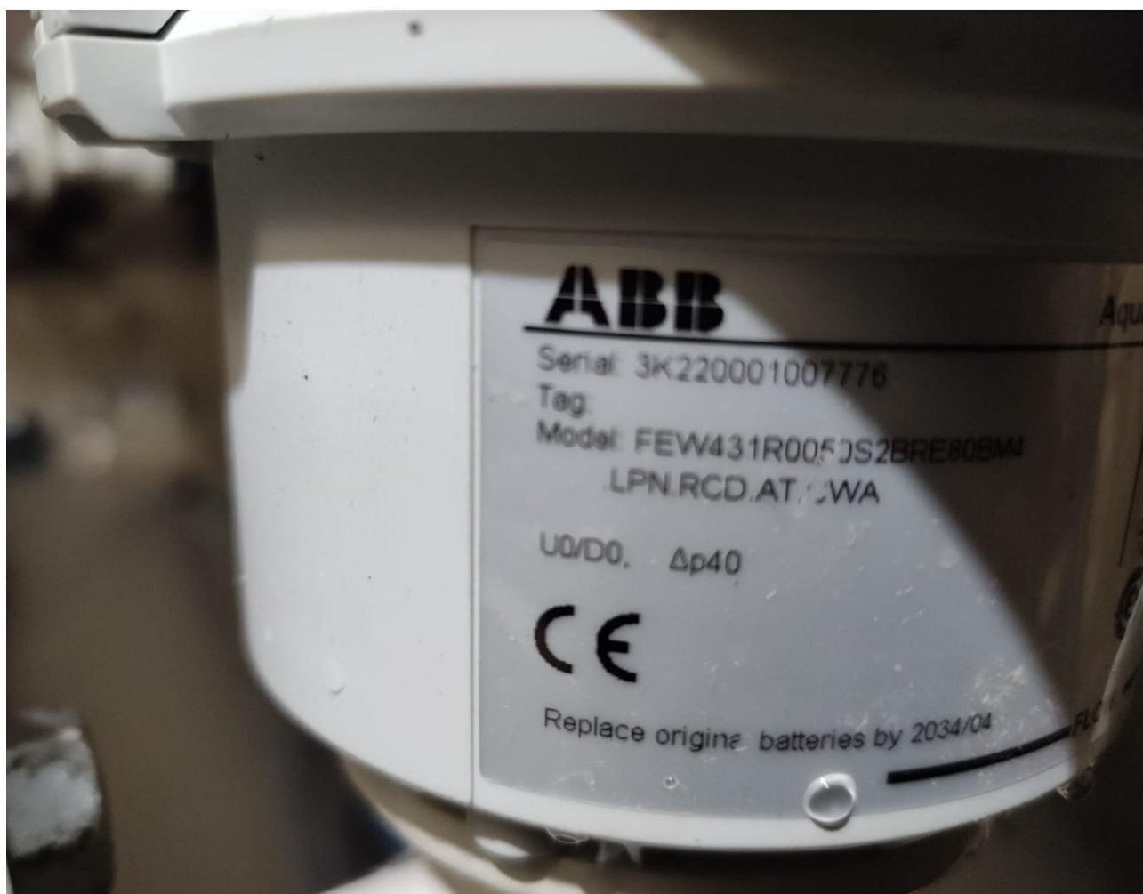
Misuratore di portata DN50 ATELETA, Serbatoio Ateleta 1Alto ID:ATL_Q09 Codice 3K220001007776
