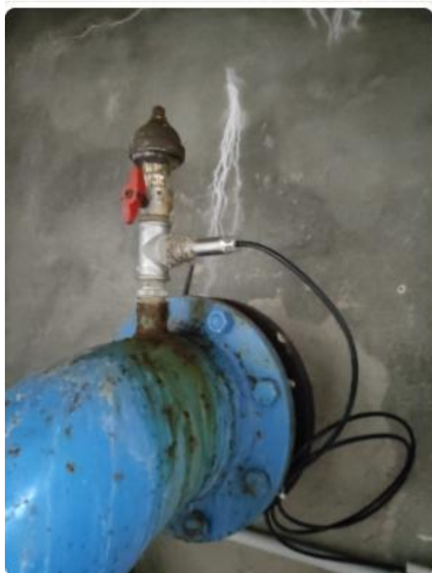
Misuratore di pressione Serbatoio PARTITORE di Rivisondoli ID:RIV_P01 Tipo Keller pn 222625,1245 11/24
