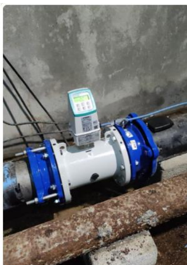
Misuratore di portata , SIEMENS DN200 SERBATOIO PARTITORE DI RIVISONDOLI ID:RIV_Q01 CODICE 040003H413
