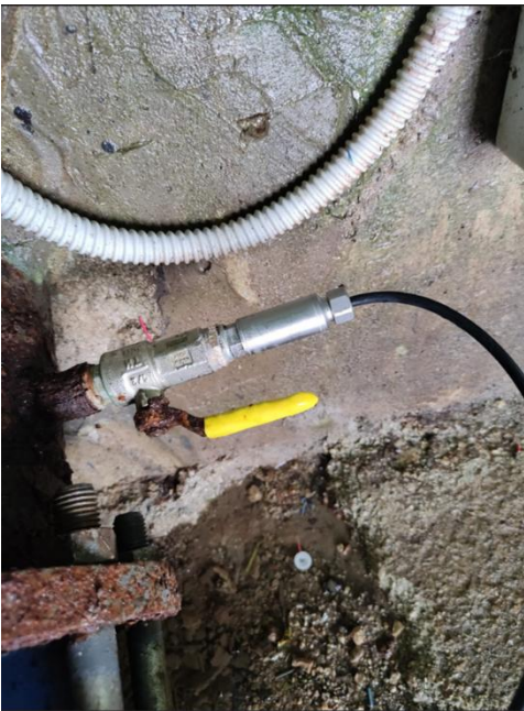
Misuratore di pressione BUGNARA (Serbatoio Comunale) ID: BUG_ P01
