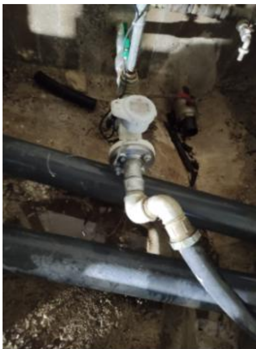
Misuratore di portata DN 50 CIVITELLA ALFEDENA Serbatoio LE CIPPETTA ID:CIV_Q01 CODICE 3K220001007780
