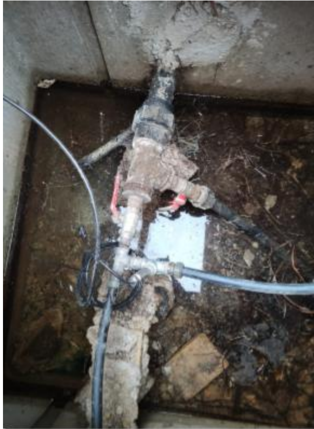
Misuratore di pressione Pettorano sul Gizio (pozzetto) ID: PET_P06 TIPO KELLER PN 222625,1245 11/24
