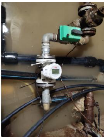
Misuratore di portata DN50 ATELETA, Serbatoio Ateleta 1Alto ID:ATL_Q09 Codice 3K220001007776
