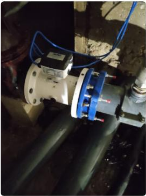
Misuratore di portata DN150 CIVITELLA ALFEDENA serbatoio LE CIPPETTA ID:CIV_Q02 CODICE: FM MAG 052902H345
