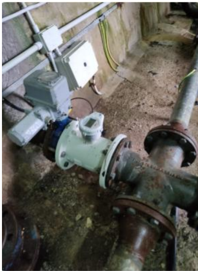
Misuratore di portata DN150 BUGNARA (Serbatoio Comunale) ID:BUG_Q01 CODICE:3K220001037809
