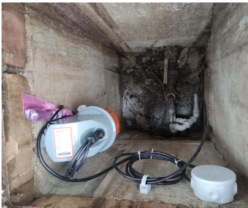
Misuratore di pressione BUGNARA (Rete comunale pozzetto) ID: BUG_P05
