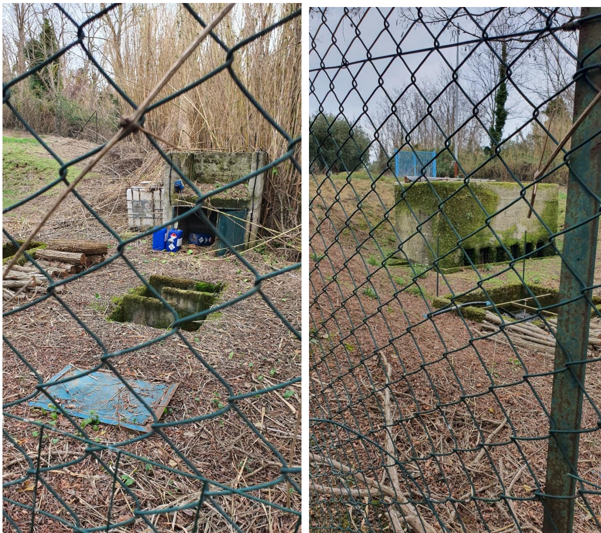
Figura 3-1 Da sinistra in alto a destra: 4 bacini combinati, a sistema Imhoff, prefabbricati in CAV e vano di contatto per la sterilizzazione chimica (foto 1); percolatore a pianta rettangolare (foto 2).
