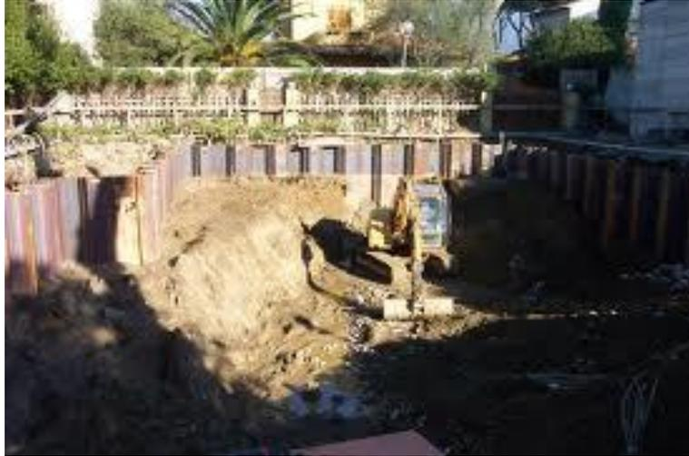
Figura 3-1: Palancole di sostegno dello scavo
