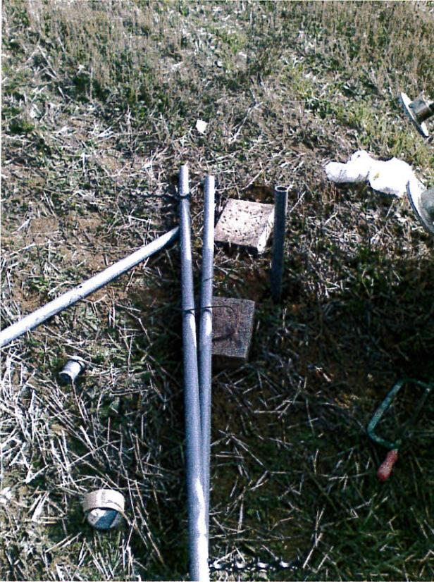
*Foto n°5* – Installazione piezometri.
