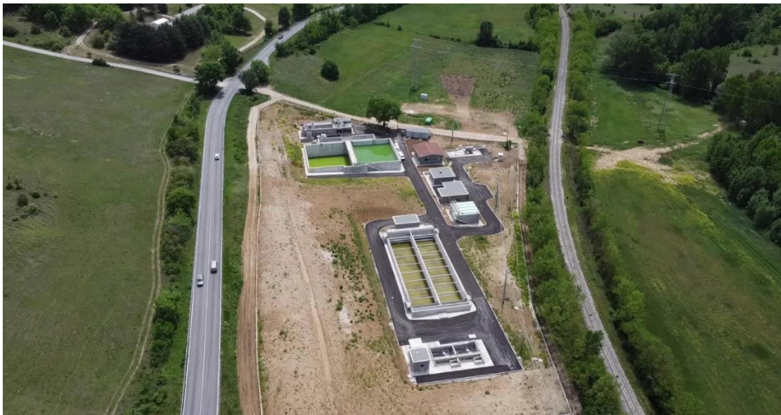
2-1 - Vista Aerea dello Stato di Fatto dell'Impianto di Depurazione di L’Aquila
