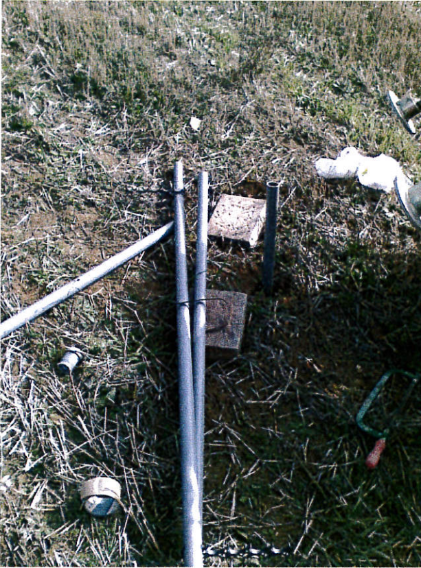
Foto n°5 – Installazione piezometri.
