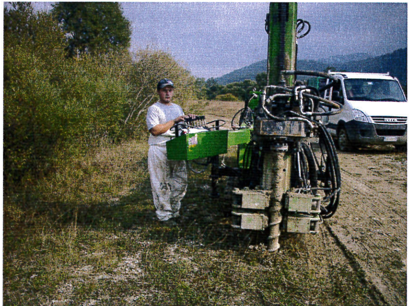
Foto n°6 – Postazione sondaggio geognostico S1.
