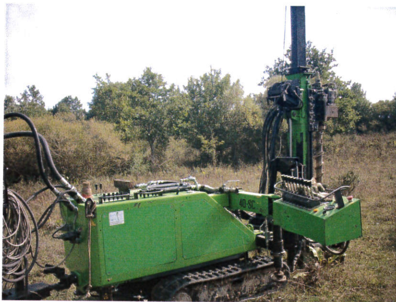
Foto n°7 – Postazione sondaggio geognostico S2.
