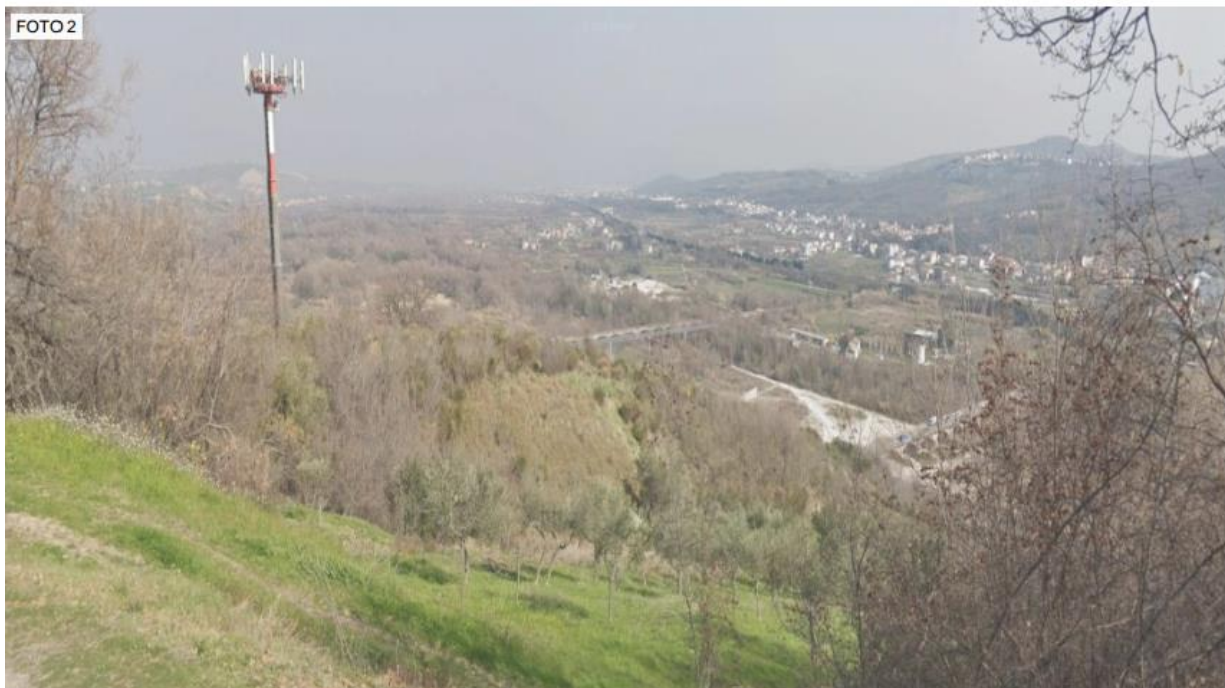
Figura 203 – Viste dell'attraversamento Fiume Sangro dalla SP110
