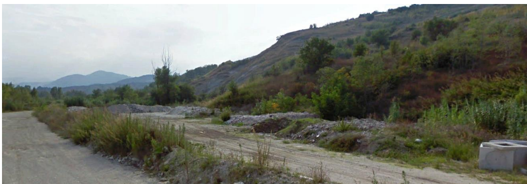
Figura 198 – Stato attuale Area di cantiere Attraversamento N. 2 – Stralcio 2
