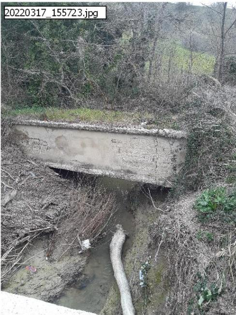
Figura 34 – Attraversamento aereo condotta esistente in prossimità della posa della condotta in progetto – Stralcio 2.
