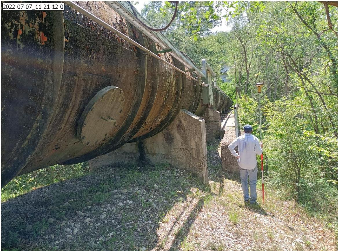
Figura 39 – Condotte di adduzione esistente alla quale si collegherà una delle due derivazioni in progetto – Stralcio 3.
